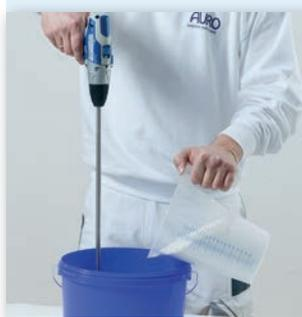
Mischen Sie das Profi-Kalkspachtel-Pulver mit Wasser entsprechend der Packungsanleitung. Dafür eignet sich ein Rühraufsatz für die Bohrmaschine. Das Pulver muss gut aufgelöst werden.
