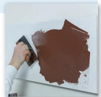
In schwunghaften Zügen arbeiten, bis Seidenglanz entsteht. Die optimale Schichtdicke ist max. 1 mm. In unserer Videoanleitung (siehe Rückseite) können Sie sich diesen Vorgang genauer anschauen. Die Wand 12 Stunden trocknen lassen.
